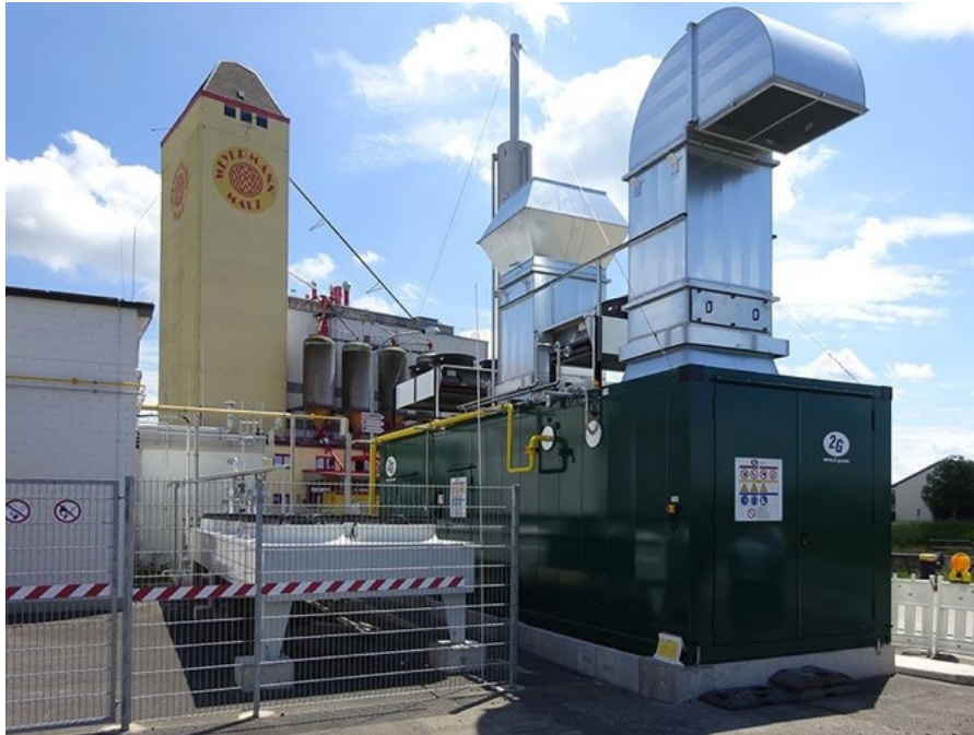
Abbildung 24: Das H 2 -BHKW agenitor 406 SG von 2G (Amberg-Weiden, 2020)
